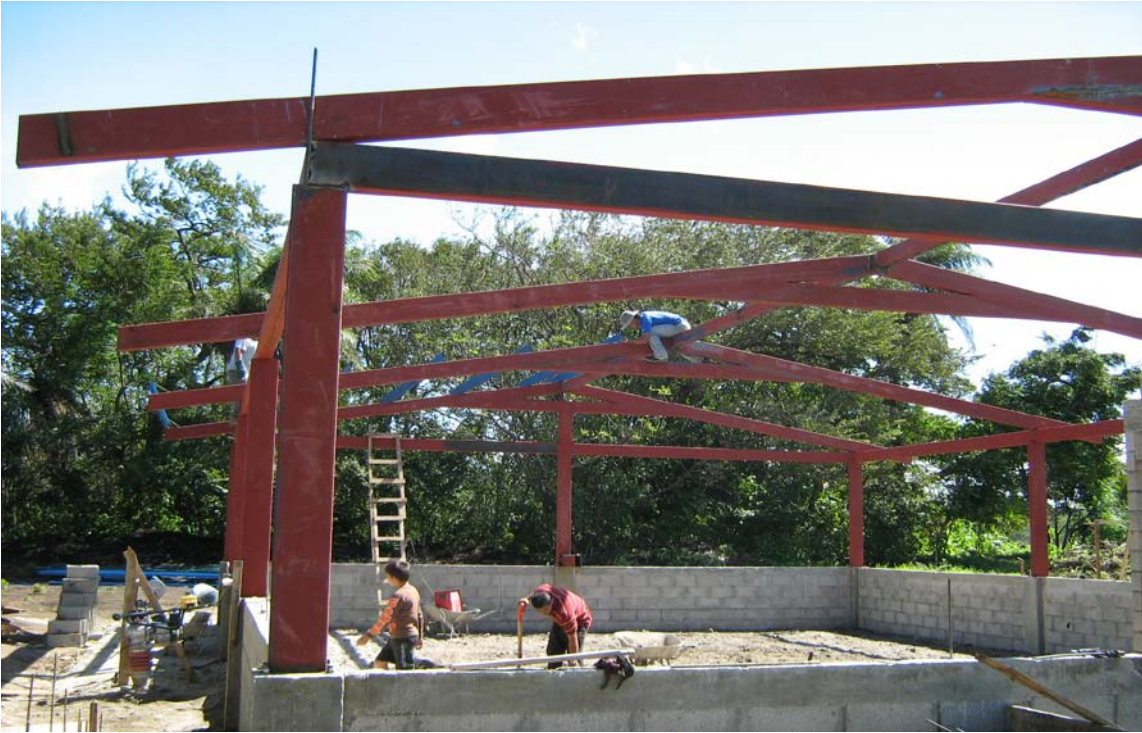
Foto 1. Avance de la construcción del centro de acopio
