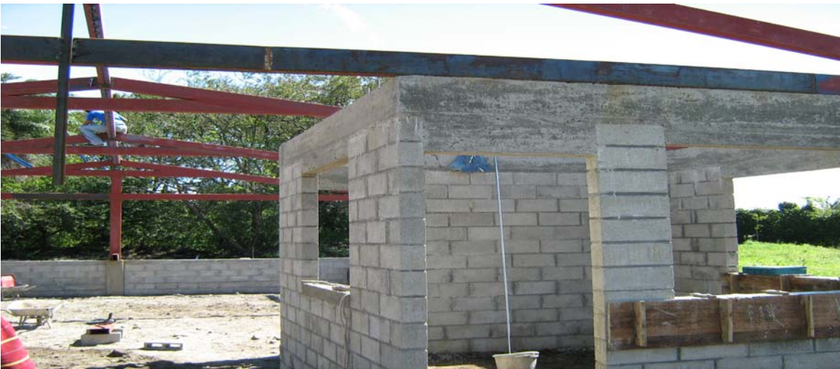
Foto 2. Avance de la construcción del centro de acopio
