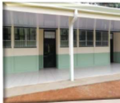
Foto 4. Construcción de aula Escuela Reserva Indígena Tayni, Región Caribe. Inversión de ₡34.066.742. Familias beneficiadas 228
